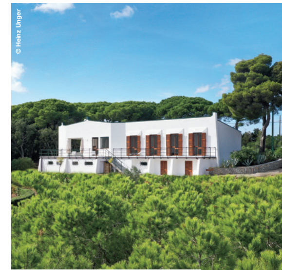
Der Charme der 1960er Jahre wurde dank der Sanierung zu neuem Leben erweckt.
