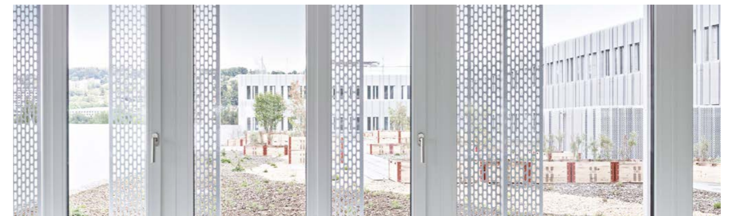
Bandfenster mit Fassadenelementen zum Innenhof
