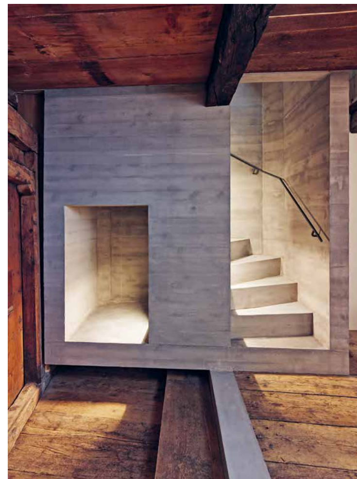
Oben links Das Treppenhäus wird lediglich von einem Unterzug aus Sichtbeton getragen. Stufen, ebenfalls aus Beton, führen ins offene, helle 2. Obergeschoss.
